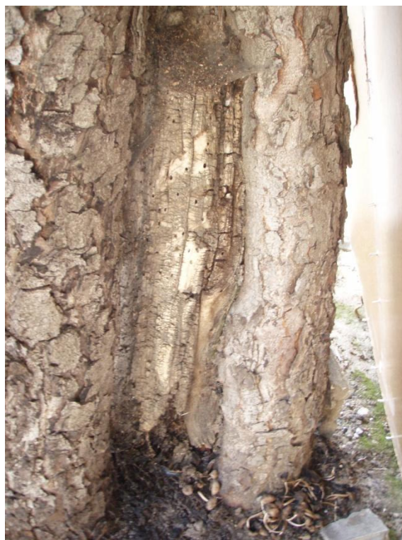
Слика 75. Оштећења од инсеката и насељавање гљива трулежница на дрворедном стаблу
